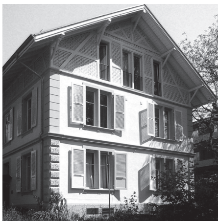
Gebäude der Soteria Bern
